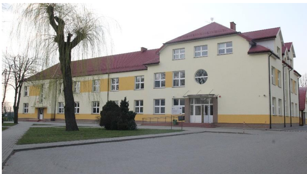
Termomodernizacja budynku szkoły w Nowych Piekutach
