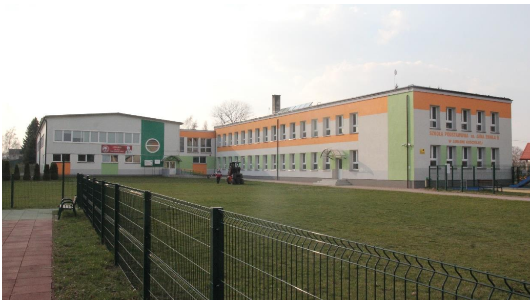
Termomodernizacja budynku szkoły w Jabłoni Kościelnej i przebudowa Sali gimnastycznej
