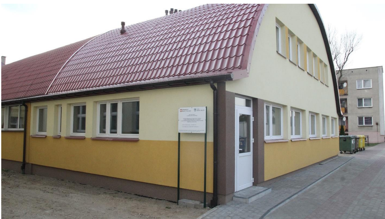
Przebudowa i remont sali gimnastycznej w Nowych Piekutach
